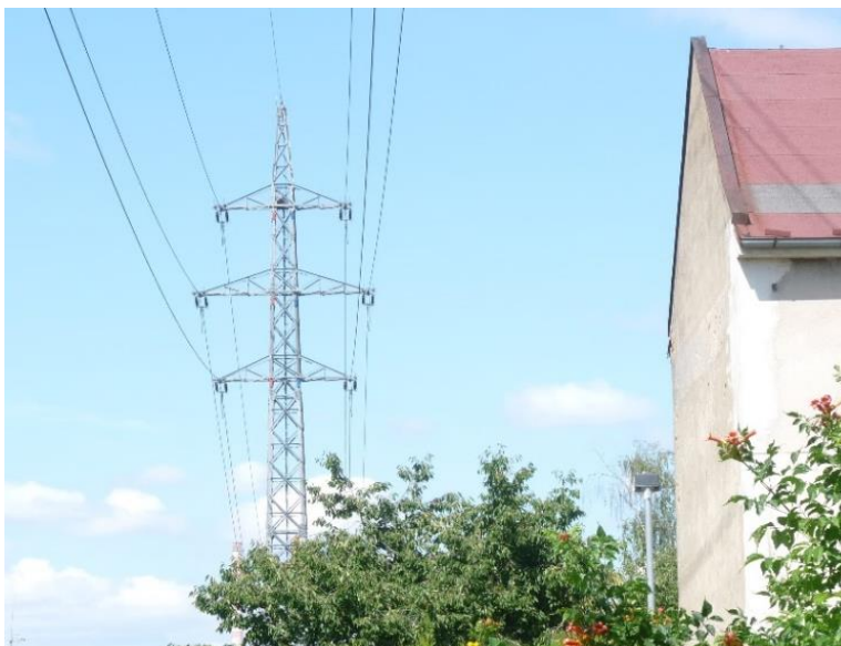
Obrázek 2:110 Nejkratší vodorovná vzdálenost vedení VVN od budovy 3,1 m
