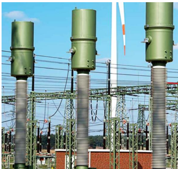
Obrázek 2:77 Přístrojové transformátory proudu 13
