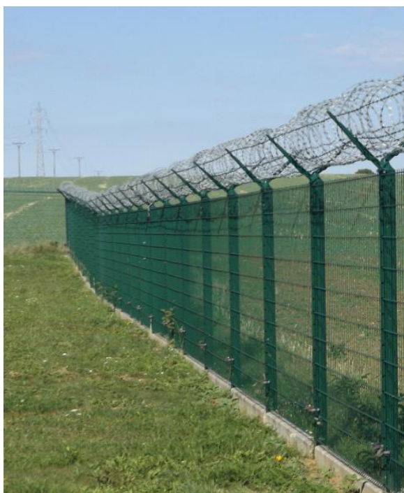
Obrázek 3:55 Vnější oplocení rozvodny 110/22 kV
