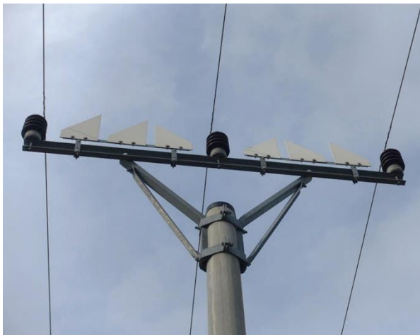
Obrázek 2:39 Rovinná konzola s ochranou proti dosedání ptactva
