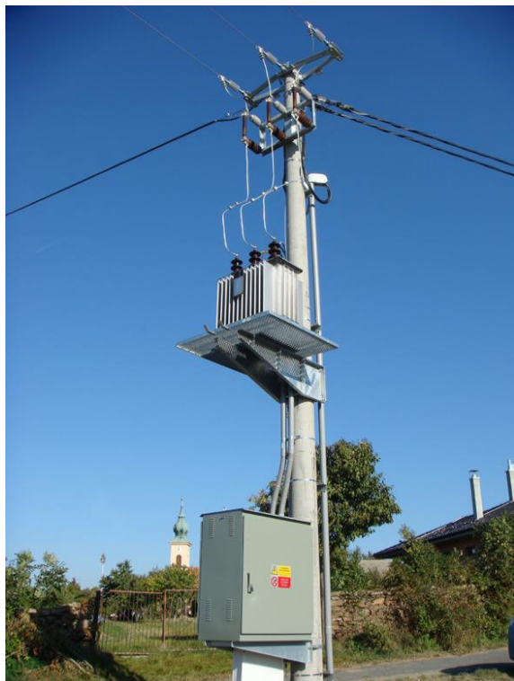
Obrázek 2:21 Distribuční jednosloupové trafostanice jako zdroj pro síť NN
