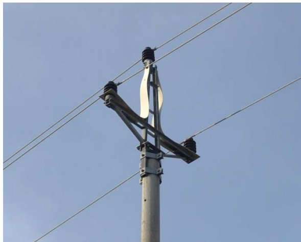
Obrázek 2:40 Konzola Delta s ochranou proti dosedání ptactva
