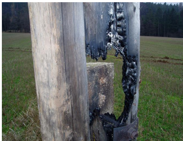
Obrázek 4:53 Poškození stožárů vedení 22 kV zemním kapacitním proudem
