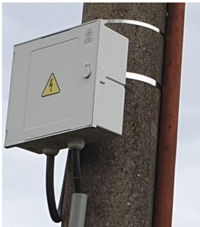
Obrázek 2:10 HDS umístěná na podpěrném bodě
