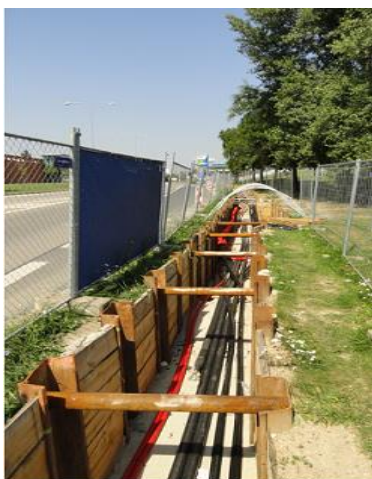
Obrázek 2:57 Výkop pro kabelové vedení 110 kV
