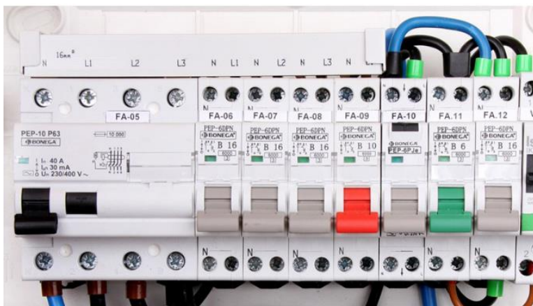
Obrázek 4:41 Modulární řazení jističů s proudovým chráničem 41
