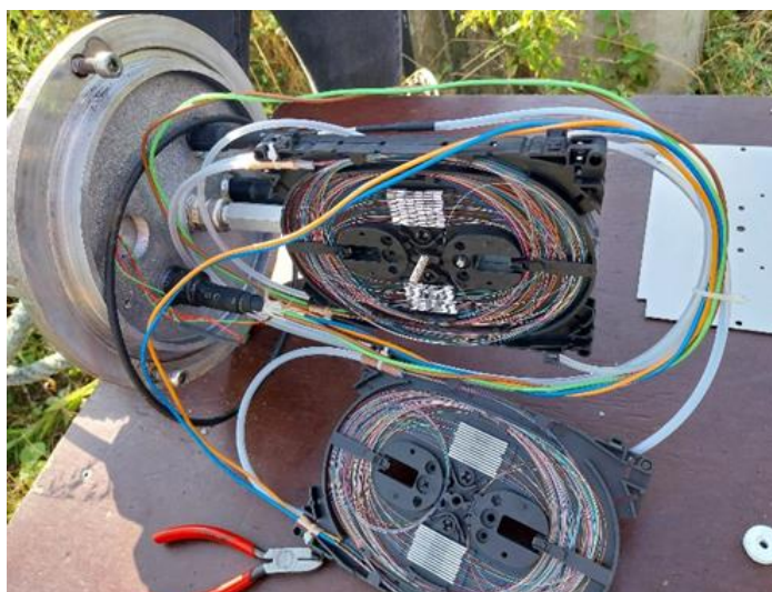
Obrázek 3:53 Spojka na kombinovaném zemním laně
