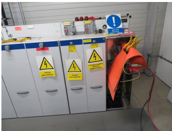
Obrázek 3:65 Diagnostika zařízení 22 kV
