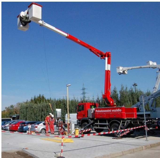
Obrázek 3:76 Zkouška pracovní plošiny PPN VN
