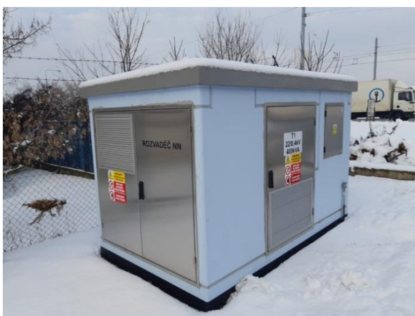
Obrázek 2:52 Kioskové trafostanice 22/0,4 kV
