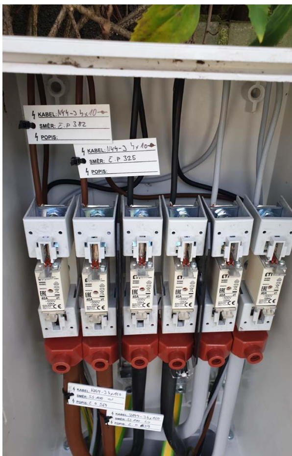
Obrázek 2:12 Připojení HDV ze smyčkovací skříně
