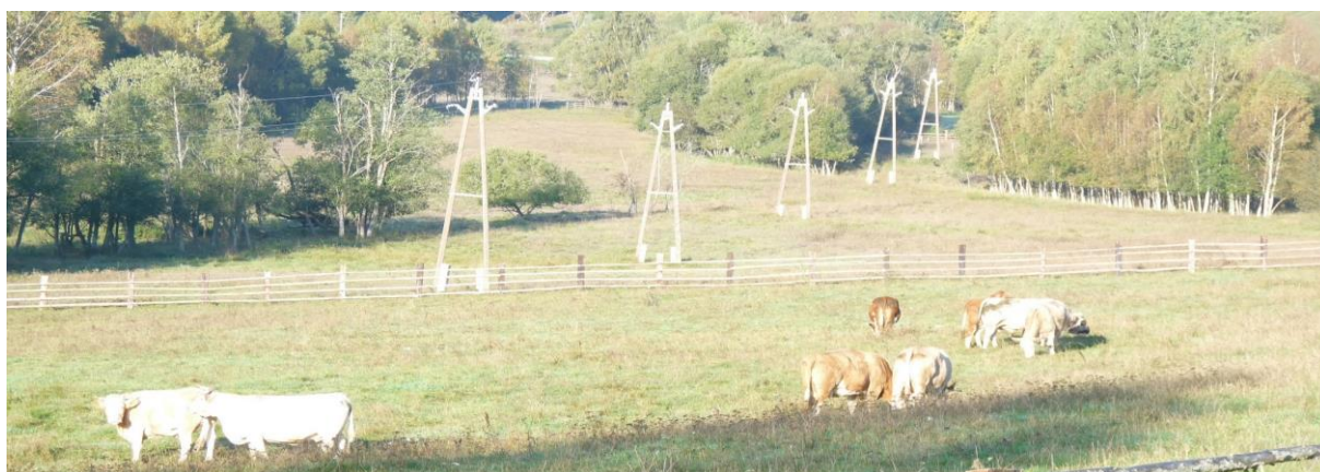
Obrázek 2:107 Nejkratší vzdálenost vedení VN nad pastvinou 6 m
