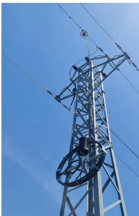
Obrázek 3:52 Spojka na ovíjeném a samonosném kabelu
