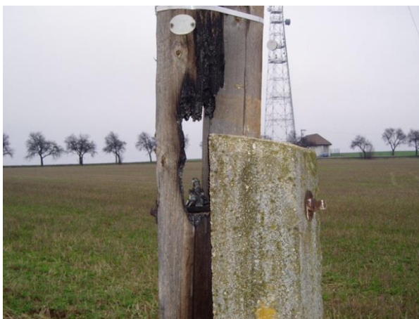
Obrázek 4:53 Poškození stožárů vedení 22 kV zemním kapacitním proudem
