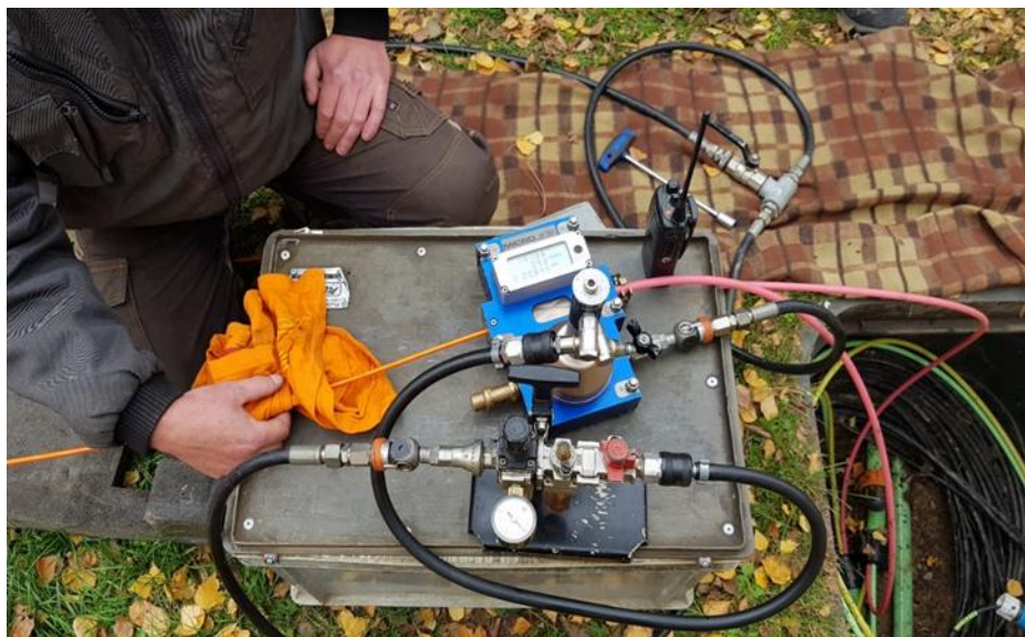
Obrázek 3:54 Zafukování mikrokabelu
