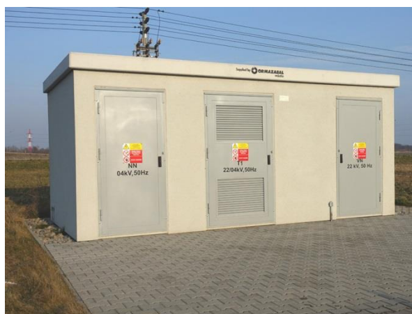
Obrázek 2:52 Kioskové trafostanice 22/0,4 kV
