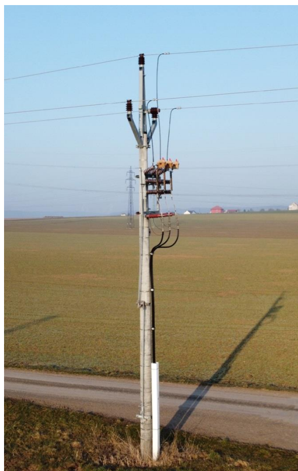
Obrázek 2:13 Kabelosvod z venkovního vedení VN
