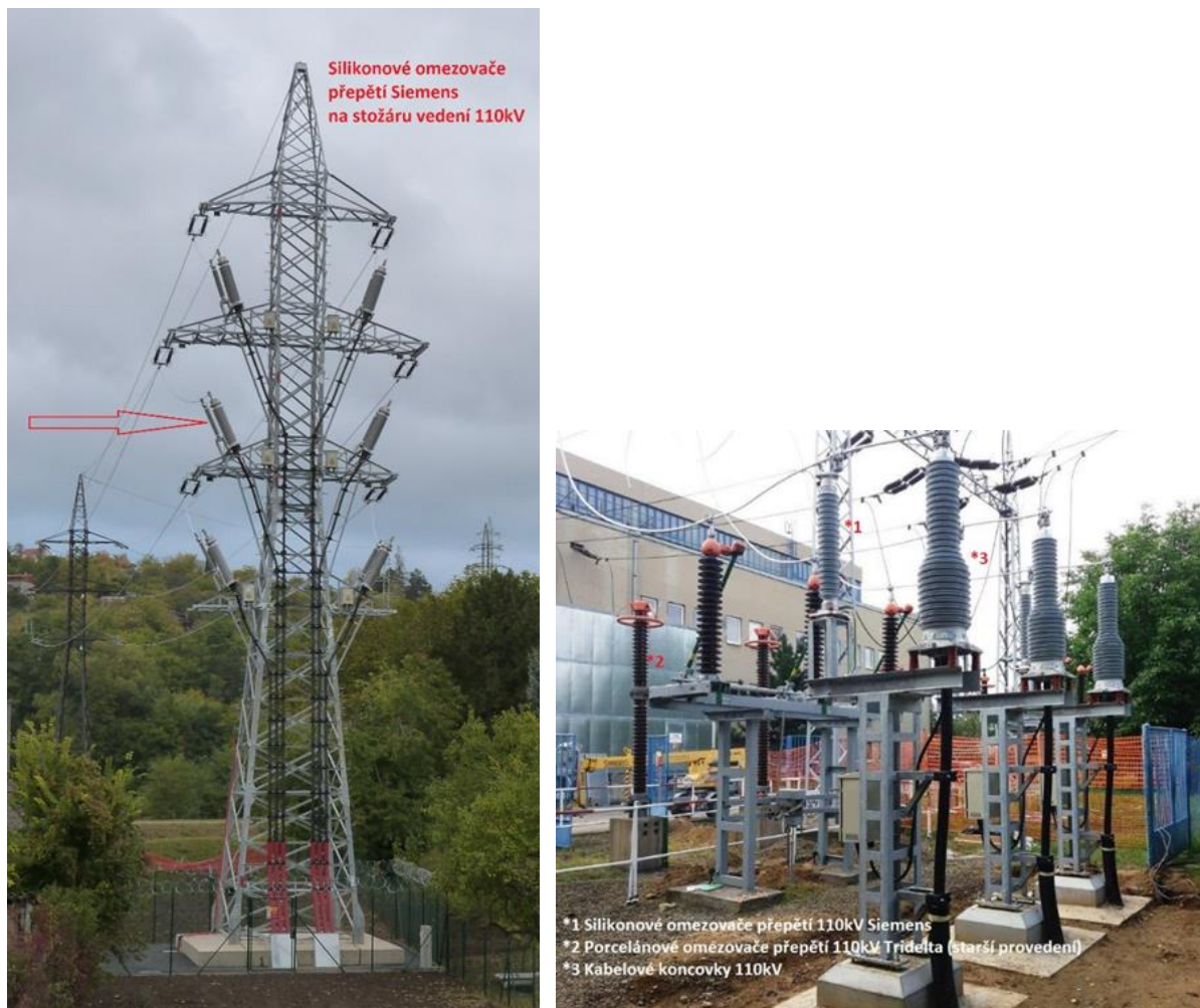
Obrázek 2:98 Omezovače přepětí v síti VVN
