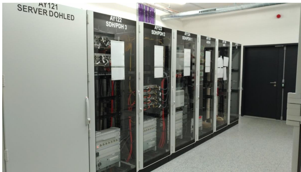
Obrázek 3:12 Skříně optických komunikací
