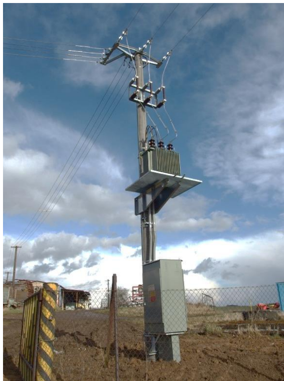
Obrázek 2:21 Distribuční jednosloupové trafostanice jako zdroj pro síť NN
