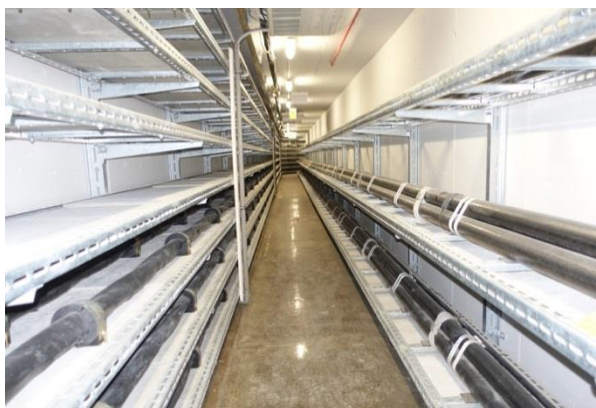
Obrázek 2:46 Podzemní kolektor
