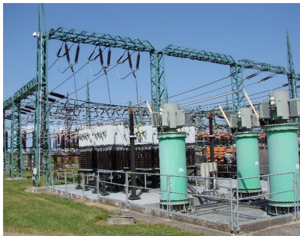
Obrázek 3:37 Vysílač HDO 110kV — vazební člen
